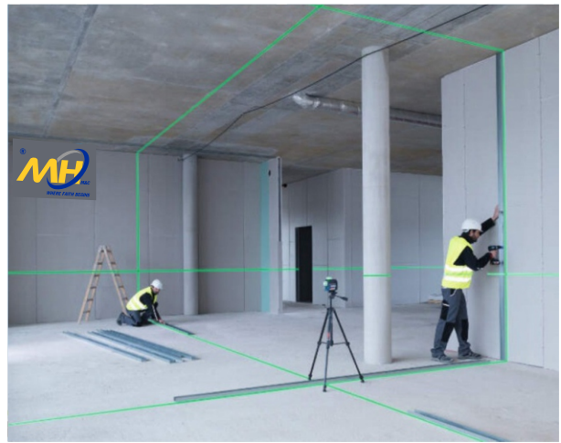
Nhà lắp ghép tấm cemboard
